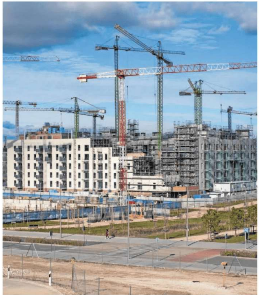
Grúas de construcción en Madrid, en enero. DAVID EXPÓSITO
